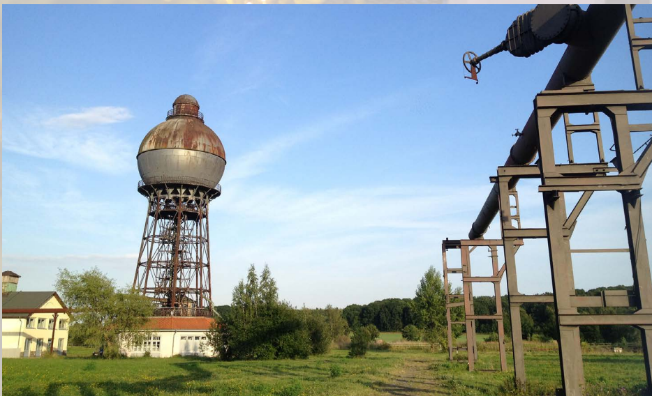
Über dem Industriepark Ilseder Hütte ragt der markante Kugelwasserturm empor.
